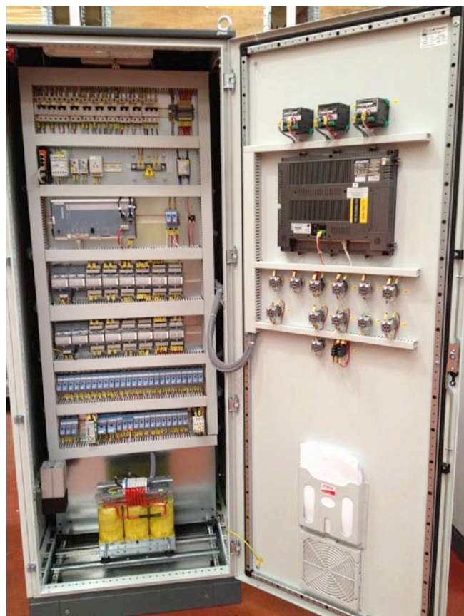
■ Cuadros electricos de control para generadores de energía hidráulica
