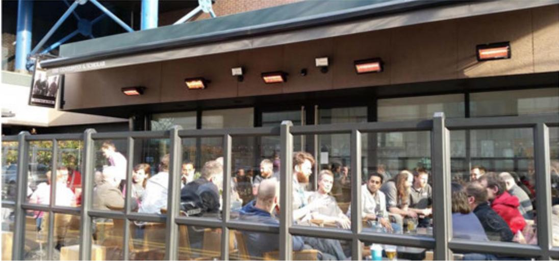
**Instalación: Terraza con Calefacción Infrarrojos de Onda Corta IR Radiant**
