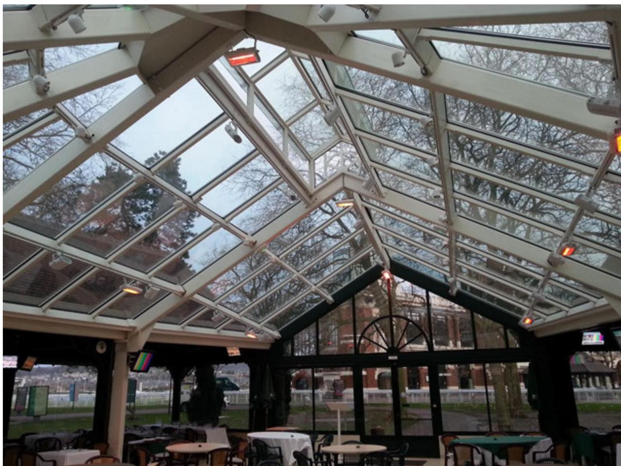
**Ejemplo de instalaciones en fabricas con techos de grandes alturas con lamparas de calección infrarrojos IR Radiant**
